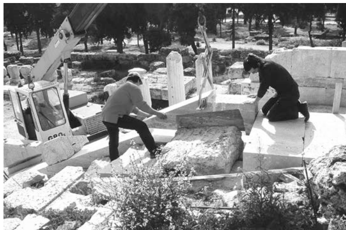
Εικ. 14: Εργασίες μερικής αποκατάστασης του αναλήμματος της δυτικής παρόδου – Εμπλοκή λίθων κεκλιμένου στηθαίου αναλήμματος και αναβαθμών κλίμακας, από Β.
