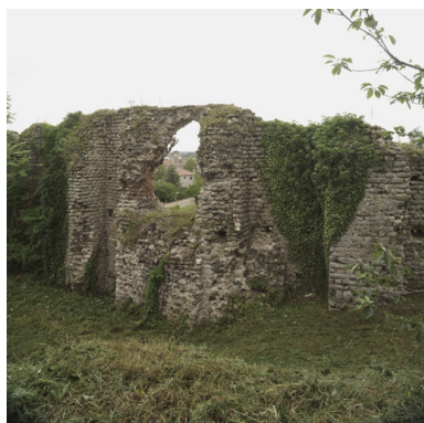
Vue générale des quelques éléments encore en élévation (au nord-ouest) du théâtre. Phot. Eric Dessert IVR82_20084200978NUCA
