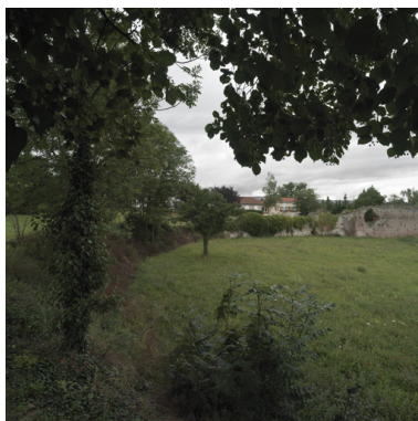
Vue d'ensemble de la partie sud du théâtre Phot. Eric Dessert IVR82_20084200976NUCA
