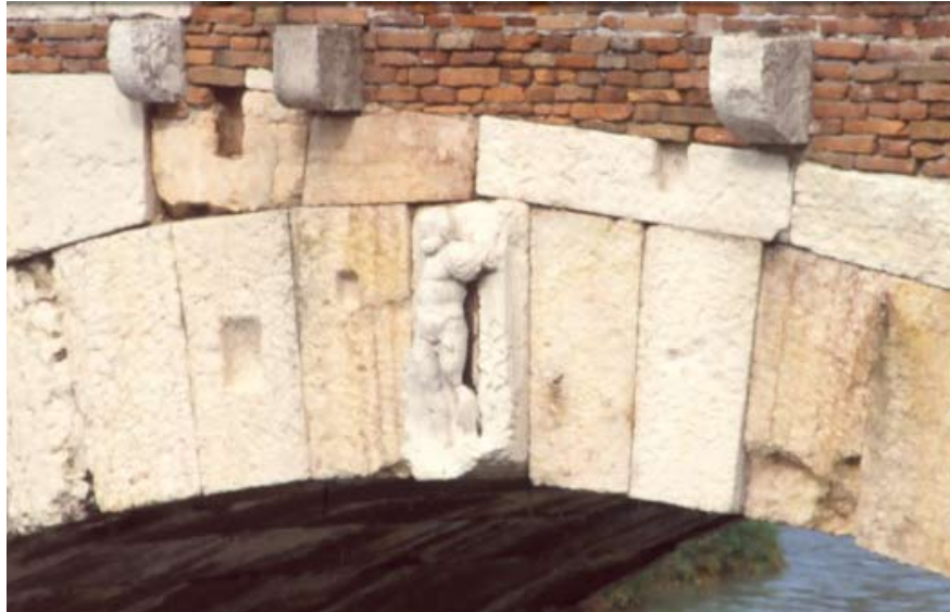
Fig. 10. Chiave di un'arcata di Ponte Pietra (foto Umberto Tomba).
